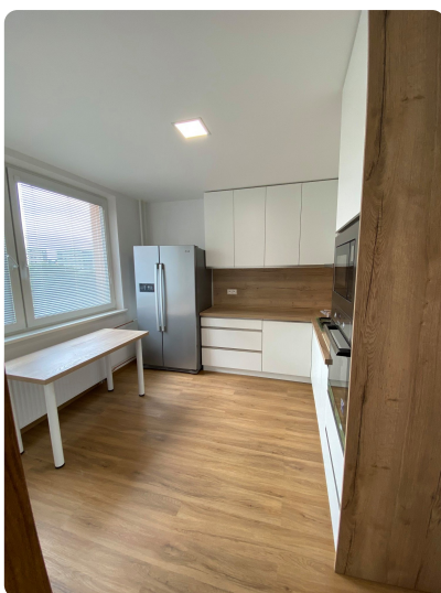
REKONŠTRUKCIA BYTU - BYTOVÉ JADRO, KUCHYŇA, CHODBA - REKOMPL
